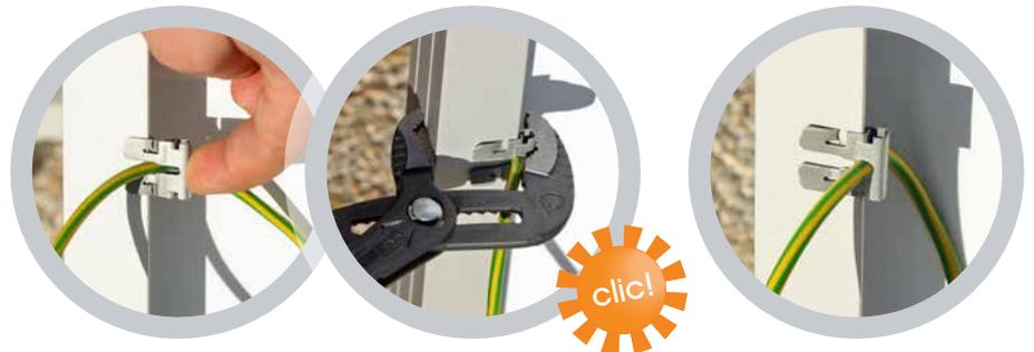
Outil recommandé : Pince standard multiprise L250mm avec mâchoires à dents et bouton de verrouillage
